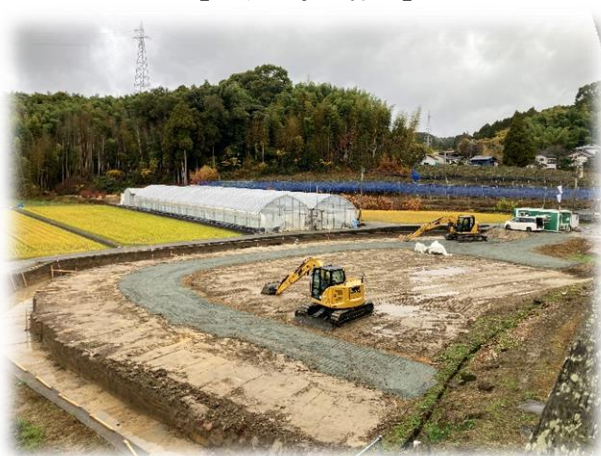
【造成工事の様子】
