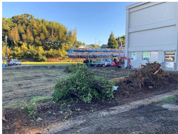
【新校舎造成工事の様子】
